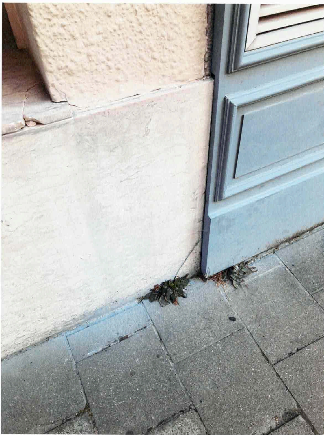
4 / Soubassement fissuré + seuil cassé
