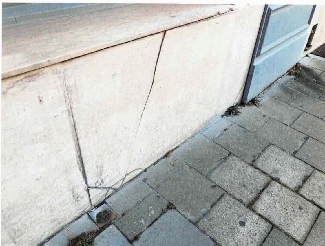
2 / Soubassement existant fissuré
